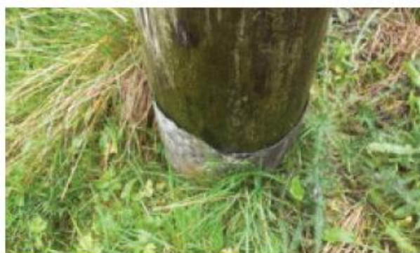
Cobra bandage (metal wrap) on pole
